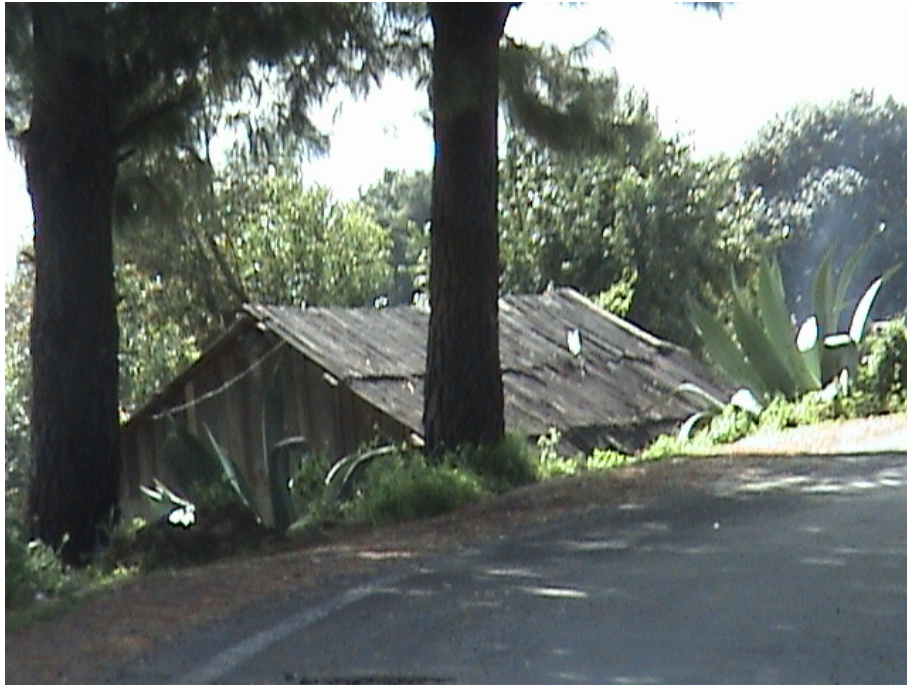
San Juan Atzingo. Las tradicionales casas de madera están casi desaparecidas.
